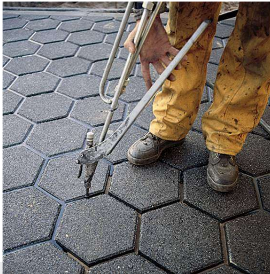
Foto: Voorbeeld van het aanbrengen van voegvulmassa.
